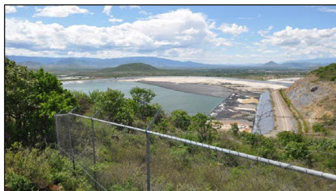
Becken mit Zyanidlauge der Cuzcatlan-Mine. Am 7. Oktober 2018 kam es nach starken Regenfällen zum Bersten des Damms. Der Inhalt ergoss sich in den nahen „Coyote-Bach“, der als Tränke für das Vieh der Bauern in der Umgebung dient und in den „Atoyac-Fluss“ mündet, der die Stadt Oaxaca mit Wasser versorgt.
