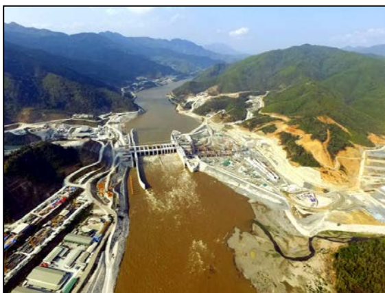
Der Xayaburi-Staudamm während der Bauphase
